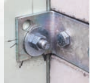
Anschließend alle Muttern wechselseitig vollständig festziehen
