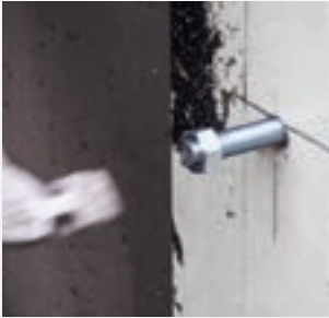
Schwerlastdübel bis zur Hälfte in Betonwand einschlagen
