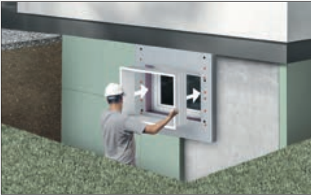
Einfache Montage des Perimeter-Abdeckrahmens
