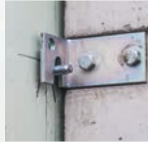
Einhängen des Lichtschachts an die Dübel
